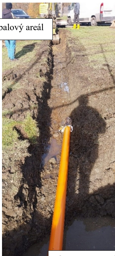
Oprava propustku u garáží
