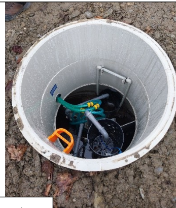
Nová ČOV – fotbalové hřiště
