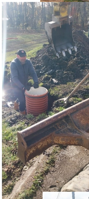
Oprava propustku u garáží
