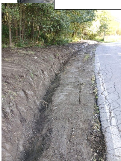
Oprava příkopu u autobusové zastávky v Nové Vsi
