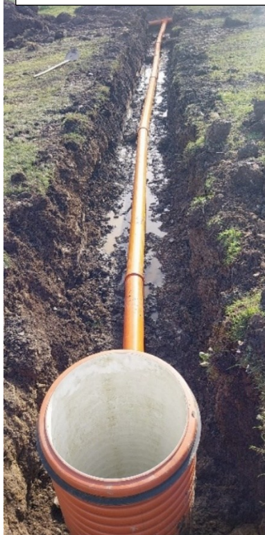
Odvodnění parkoviště – fotbalový areál
