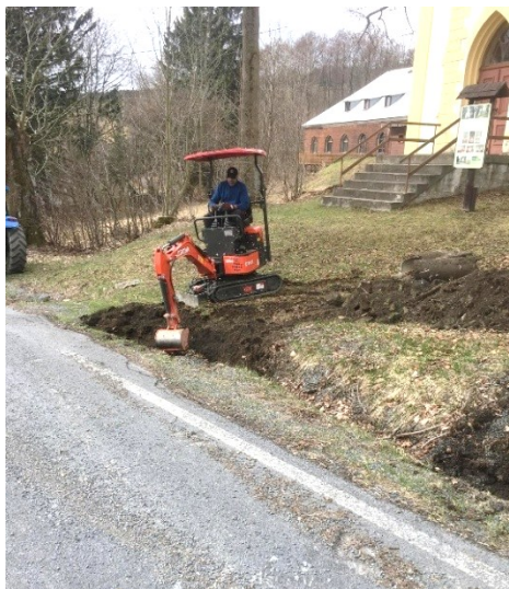
Oprava propustku u kaple
