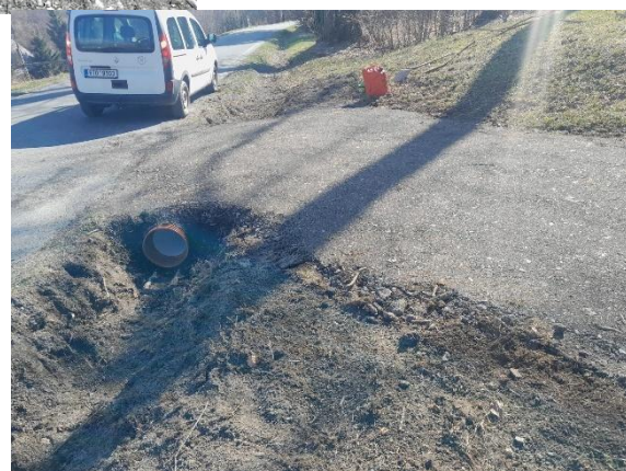
Oprava propustku u Riedlů ml.
