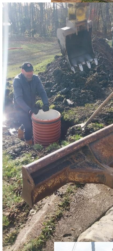
Oprava propustku u garáží
