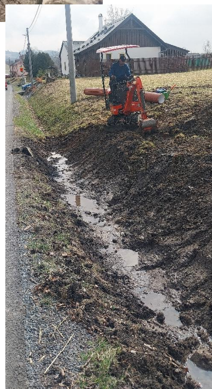
Oprava propustku u garáží
