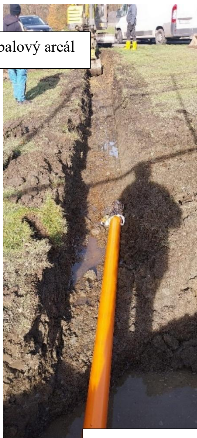
Oprava propustku u garáží
