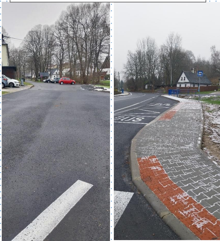
Chodníky a nová komunikace u autobusové zastávky u Domova odpočinku ve stáří.
