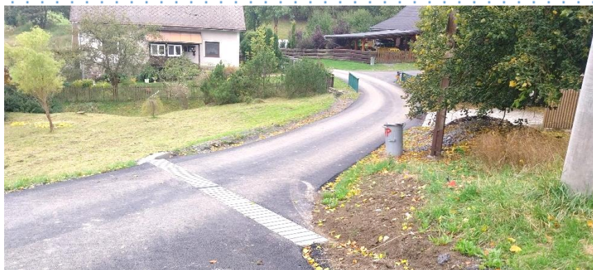
Nové komunikace na Nové Vsi a úprava odvodnění.
