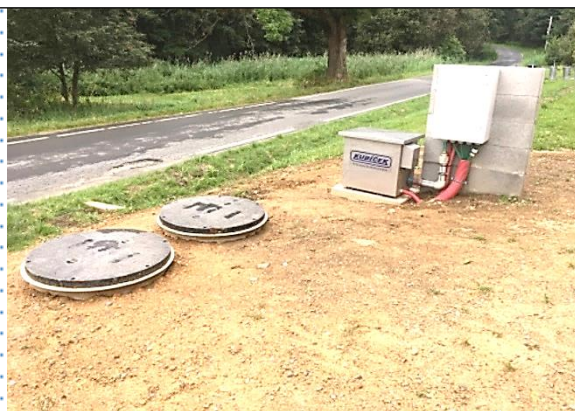
Nová čistička odpadních vod pro bytové domy č. p. 20, 21, 22 v Horní Moravici.
